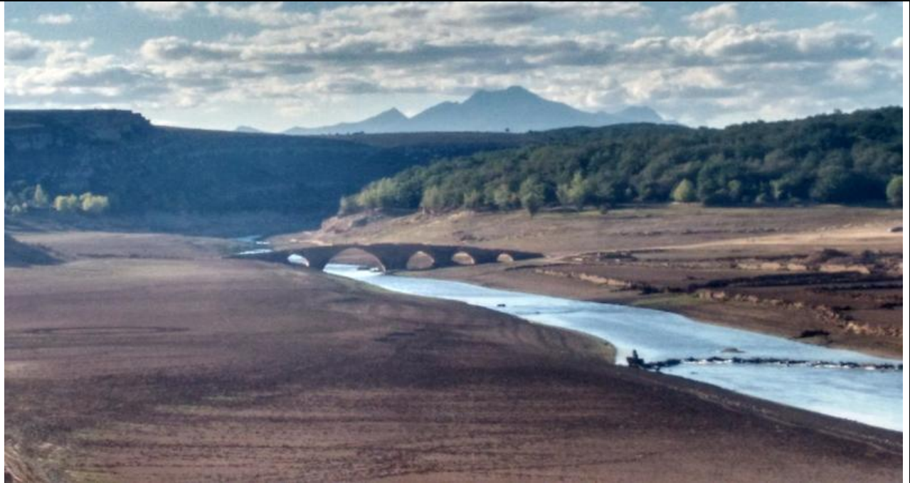
Foto del puente de Villanueva del Río , Peña Cutral y Curavacas
