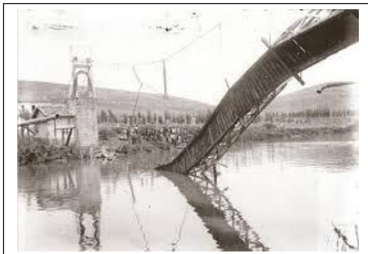
Puente colgante de la fábrica textil del Campo, en Nogales de Pisuerga (construido en 1921) Foto del accidente sufrido el día 14 de julio de 1927
