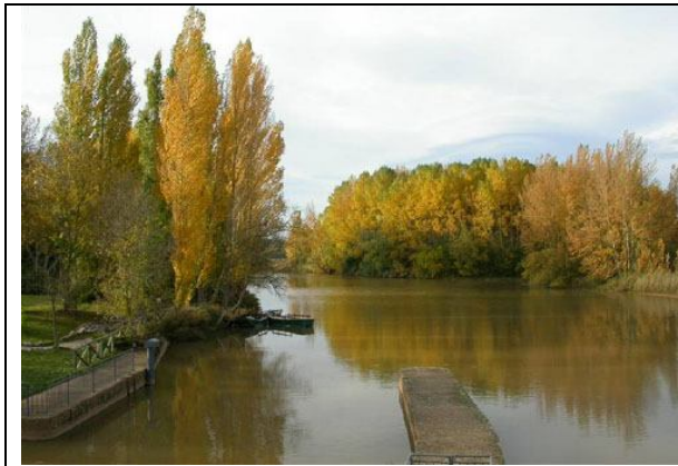
Vista de la Retención desde la presa (otoño)
