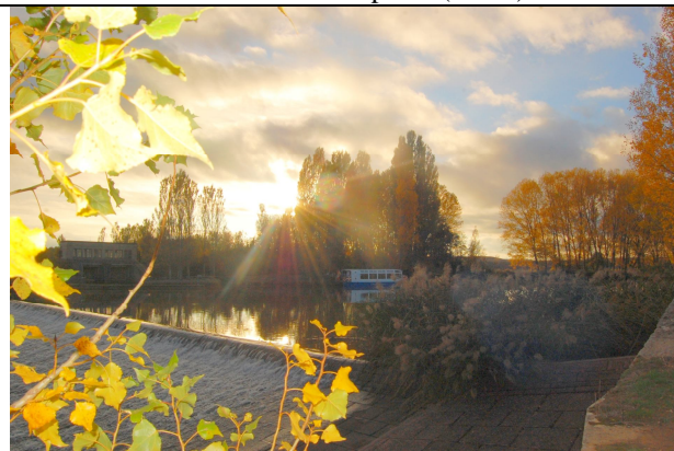
Vista de la Retención desde margen derecha
